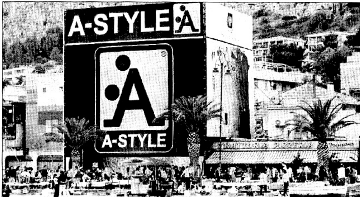
MONDELLO. La Torre nascosta dall'impalcatura per i lavori. Diventerà un museo della memoria marinara della borgata [Foto Petrx]
